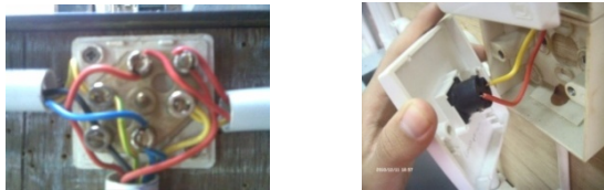
Gambar 11. Sambungan Kabel yang Benar Memakai Terminal
