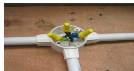
Gambar 9. Sambungan Kabel dengan Lasdop
